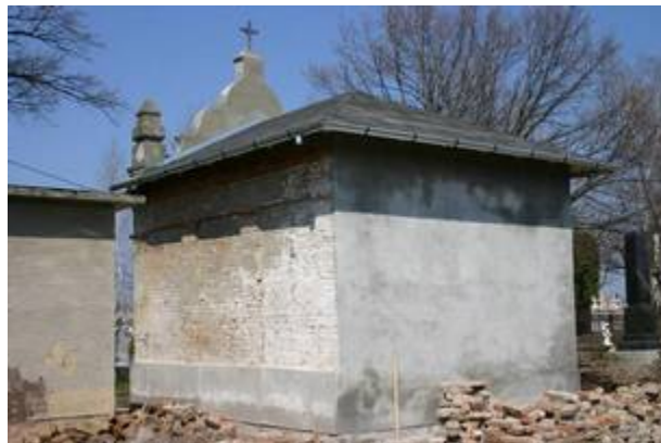
Renovierte Rückseite der Krypta
